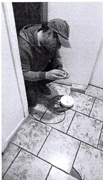
10/07/2024 Cambio y reparación luminarias baños y salón en Centro Casona Blanca
