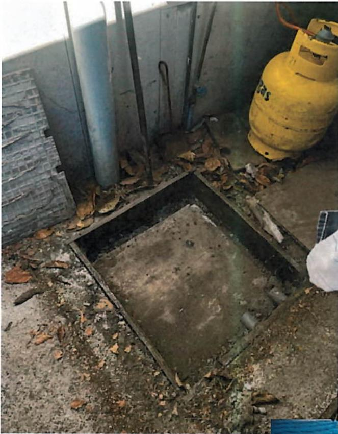
Se observa en la fotografía la conexión desde la cámara de inspección al colector en una propiedad.
