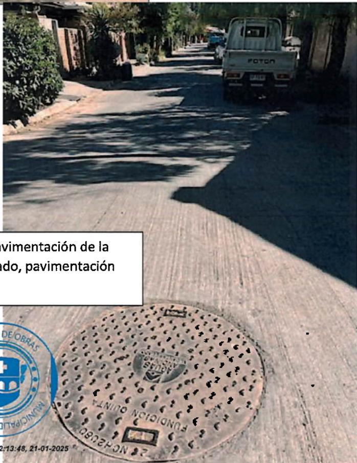
En la fotografía Calle Los Alamos, se observa la pavimentación de la vía, cámara de registro del colector de alcantarillado, pavimentación de veredas, arborización.
